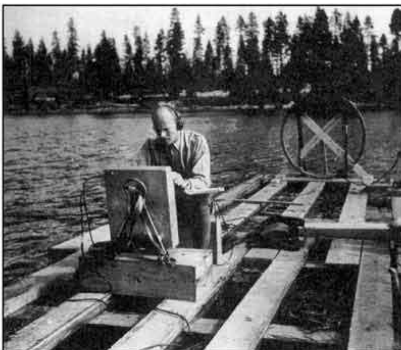
Karl-Gösta Bartoll, löjtnant ved ingenjör-tropperne, arbejder på flåden i Kölmjärv. Apparatet på billedet er et malmsøgningsapparat fra Boliden. Det anvendes i et forsøg på at lokalisere metaldele på bunden af søen.
